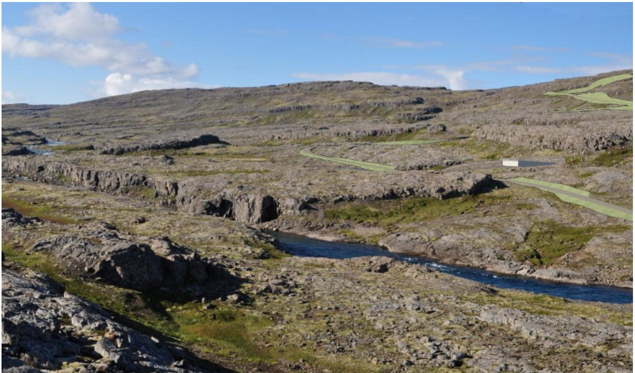
Mynd 7.44 Sama sjónarhorn og hér að ofan. Sjá má aðkomuvegi að virkjuninni hlykkjast upp fjallið og efsta hluta aðkomuhússins þar sem það stendur niðurgrafið í skurði framan við aðkomugöngin. Litir mannvirka hafa verið ýktir til að sjást betur. Vinnubúðasvæði er fyrirhugað á miðri mynd á sléttu svæði milli árinna og vegarins. Ljósmynd Verkís/SPS.
