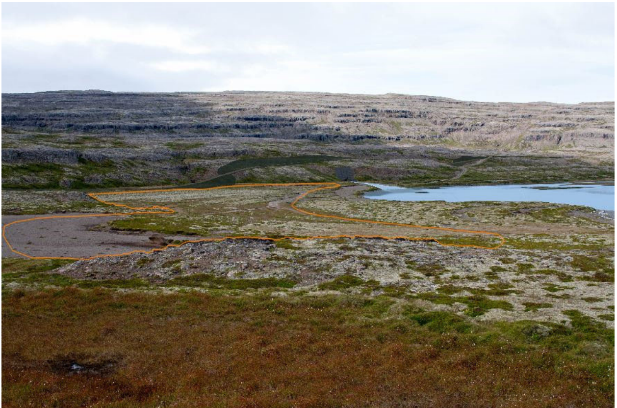
Mynd 7.46 Við Hvalárósa. Sama sjónarhorn og að ofan. Á myndinni má sjá hvar nýr vegur mun liggja í landinu, ásamt opi frárennslisganga sem opnast út í ósinn. Appelsínugula línan afmarkar mögulegt efnistökusvæði og síðar efnislosunarsvæði. Ljósmynd Verkís/EV
